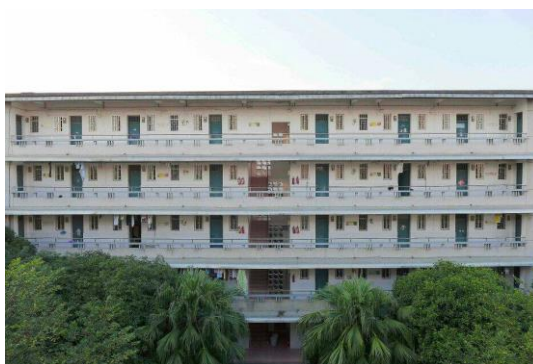
Gambar 17. Tampak Depan Asrama Beiyuan Sumber: Dokumentasi pribadi
