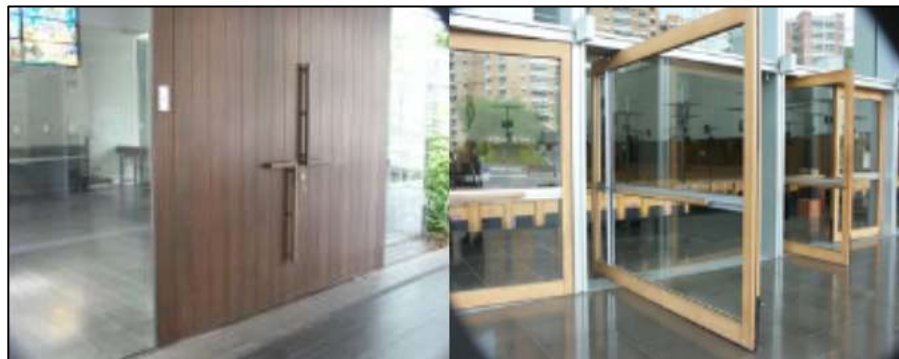
Gambar 8. Detail pegangan pintu dan gerak pintu pivot stilasi dari bentuk salib Sumber: Dokumentasi Pribadi
