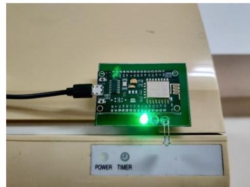
Gambar 10. IR Modul Terpasang pada AC dengan Kondisi Telah Terhubung ke Broker
