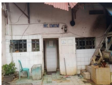
a. tampak depan salah satu toilet pada Pasar Anyar
