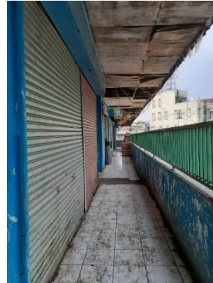
b. Koridor pada bangunan utama Pasar Anyar bagian depan
